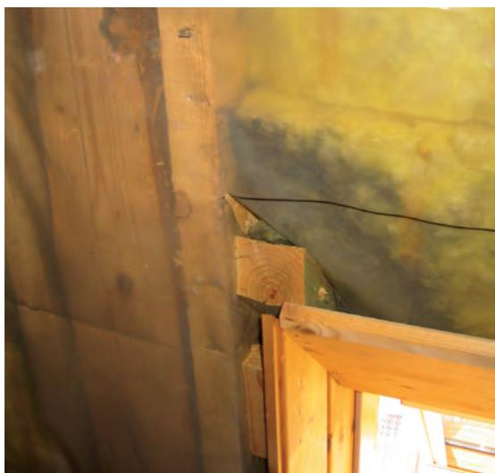
Beispiel für ein nachträglich schlecht ausgebautes Dach – die Zwischensparrendämmung wurde mit einer fehlerhaften Dampfsperre eingebaut – die Dämmung ist bereits grau angelaufen und mit Schimmel durchdrungen
