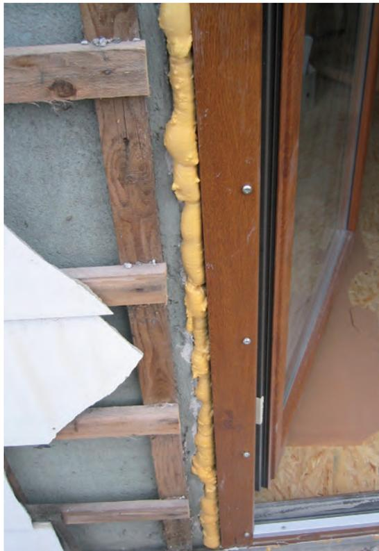
Die Fenster werden am Mauerwerk bündig eingesetzt, damit der Vollwärmeschutz darüber montiert werden kann.
